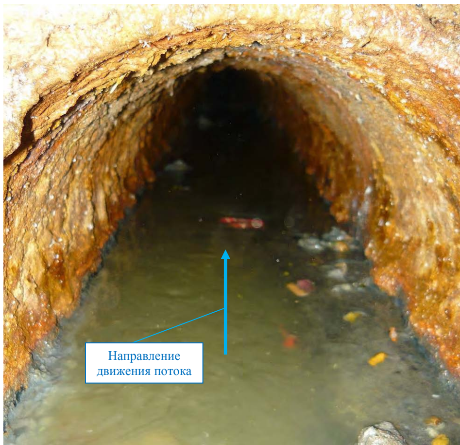
Рис. 4. Колодец КК(), состояние коллектора на выходе из колодца
